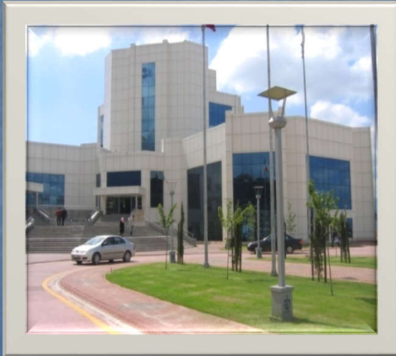
Büyükşehir Hizmet Binası (tesisi)
