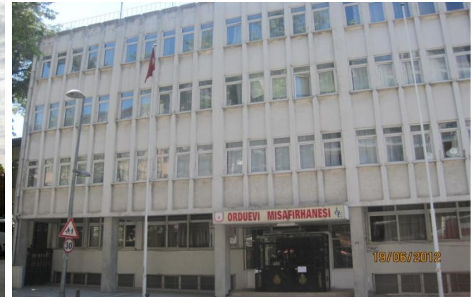
Kocaeli Orduevi Müdürlüğü Misafirhane Binası
