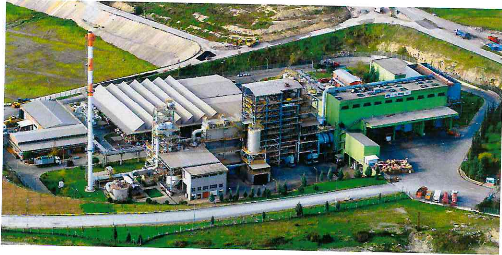
Şekil-4 Tehlikeli Atık Yakma ve Enerji Üretim Tesisi
