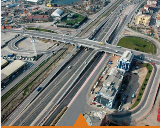
MESELA ADALET KÖPRÜSÜ
