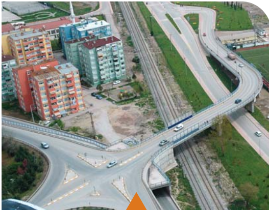
MESELA MEVLANA KÖPRÜLÜ KAVŞAĞI
