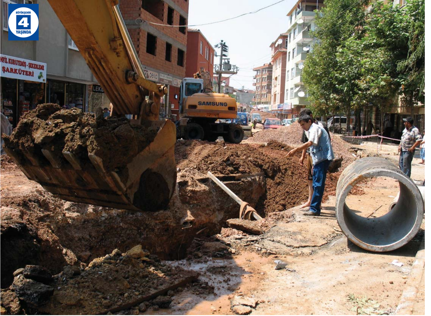
Yaşar Doğu Caddesi Yağmur Suyu Kolektör Hattı
