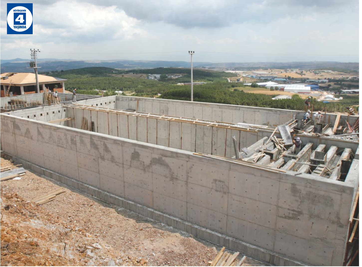
Muallimköy - Tavşanlı Köyü ve Sanayi Bölgeleri İçme Suyu Hattı
