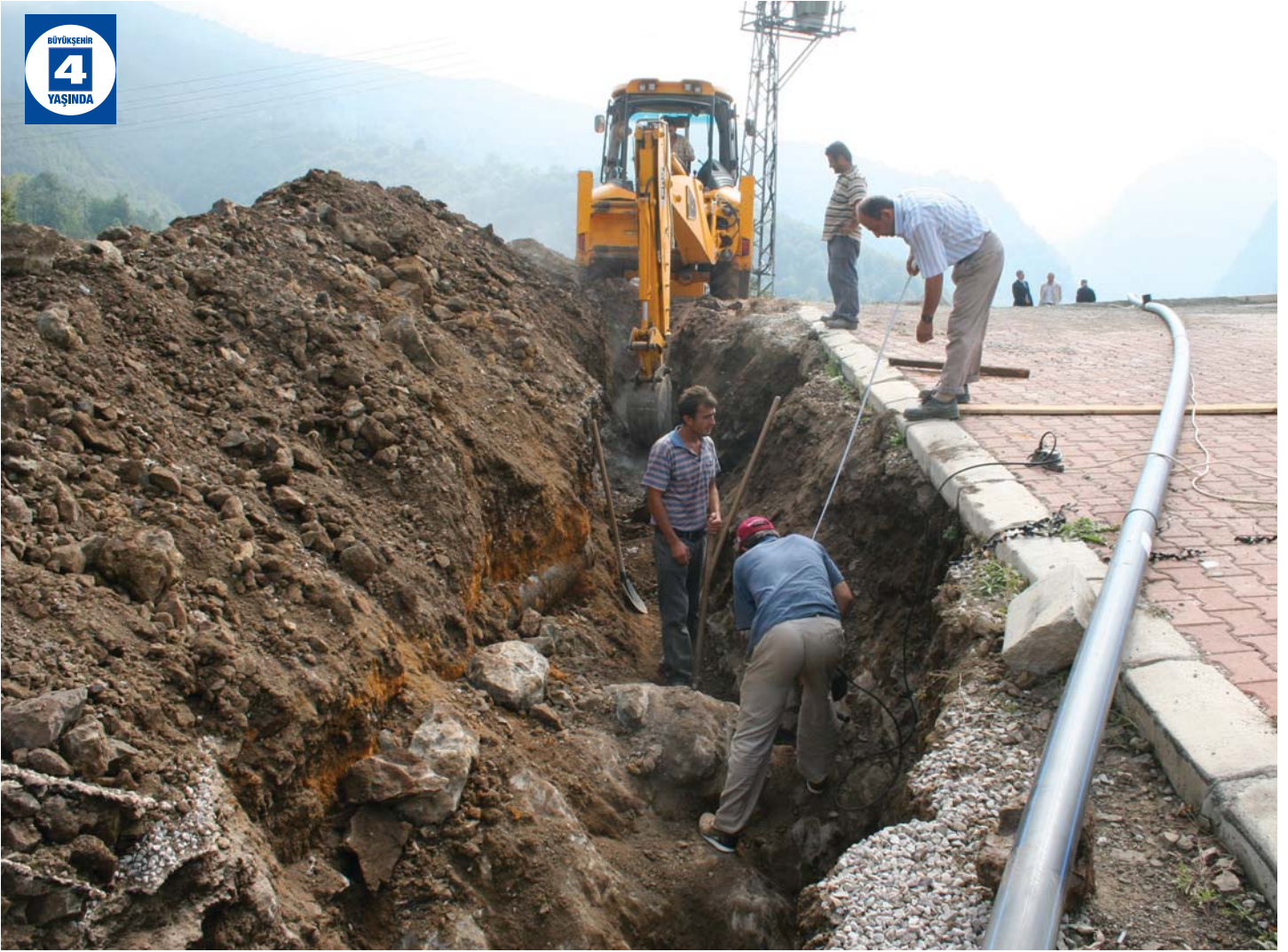
Köylerde Altyapı Çalışmaları
