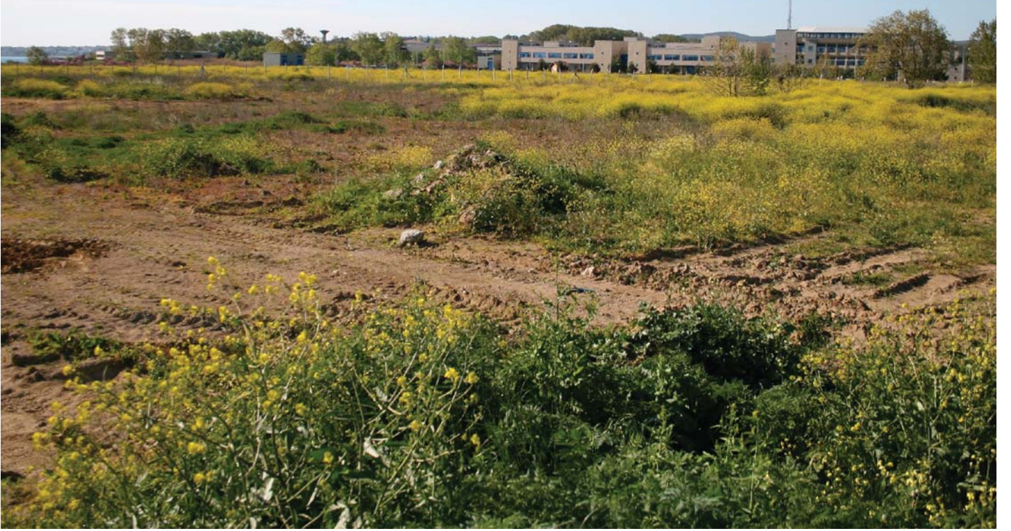
Gebze İleri Atık Su Arıtma Tesisi
