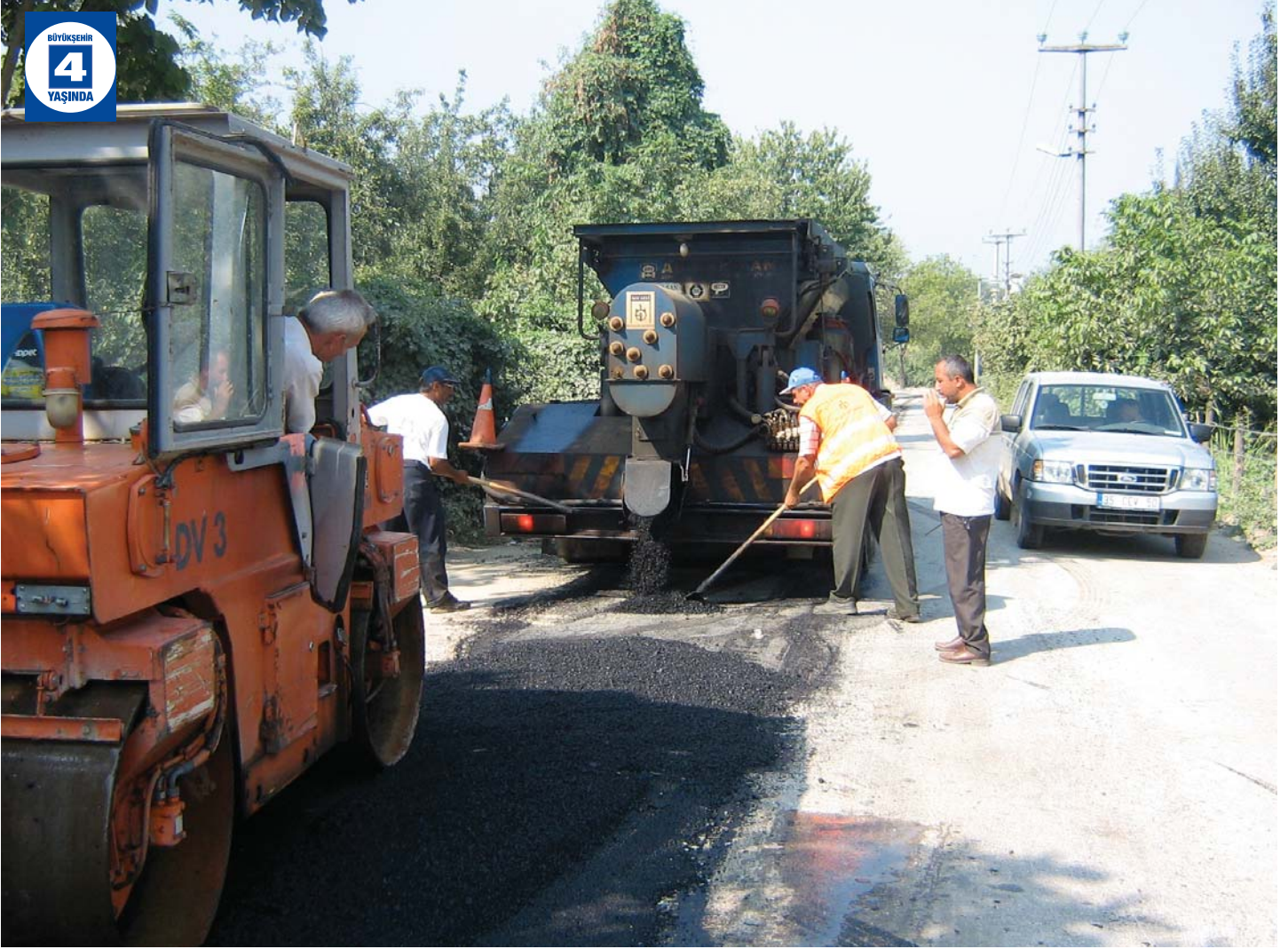
Köy Yollarının Asfaltlanması
