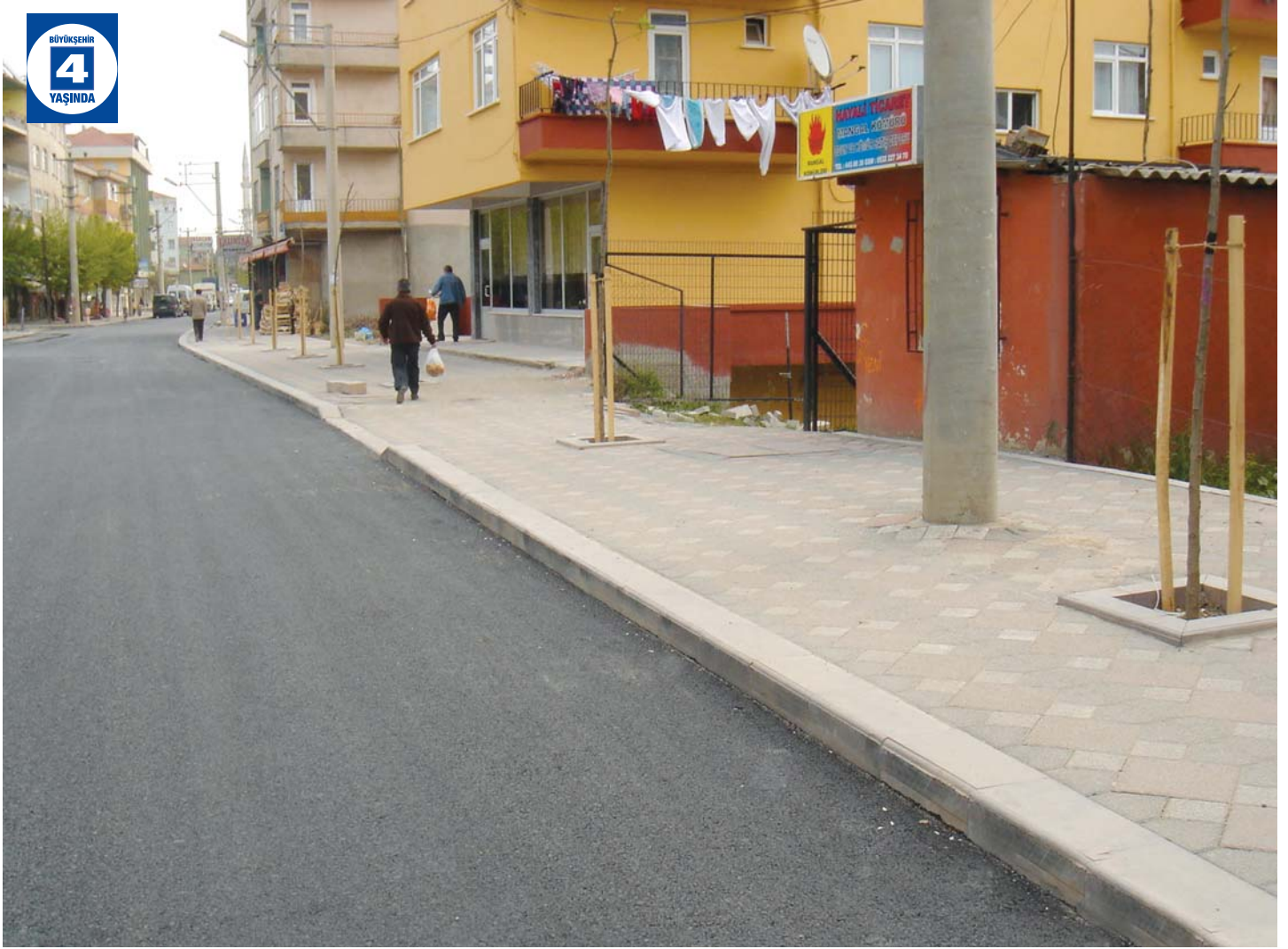
Kışla Caddesi Asfalt Çalışması
