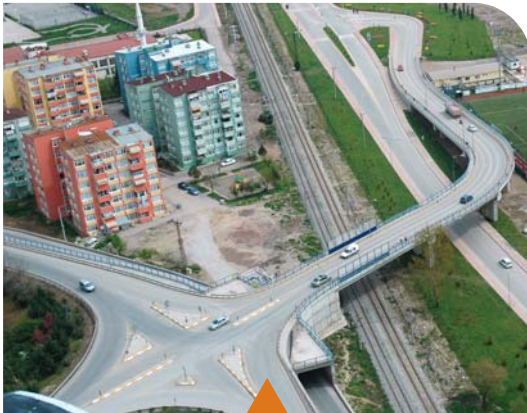
MESELA MEVLANA KÖPRÜLÜ KAVŞAĞI
