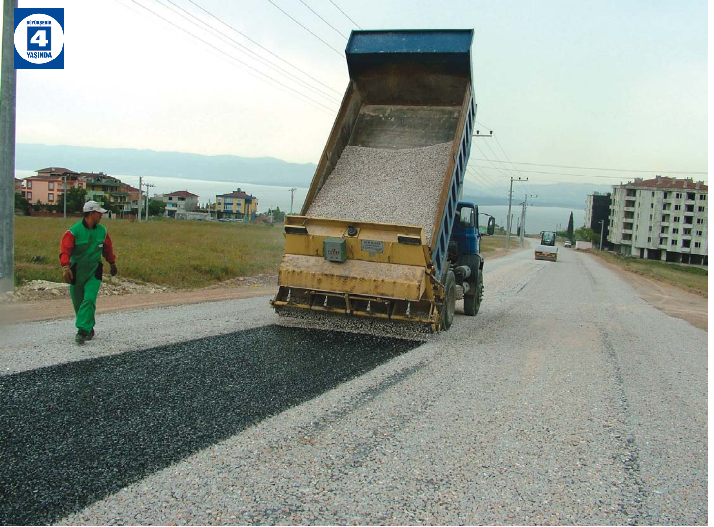
Muallimköy Yol Çalışması
