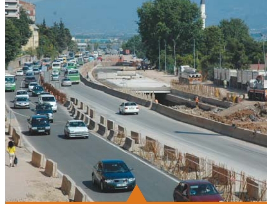
MESELA SEKA TÜNEL GEÇİŞİ
