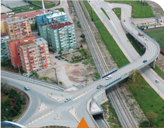
MESELA MEVLANA KÖPRÜLÜ KAVŞAĞI
