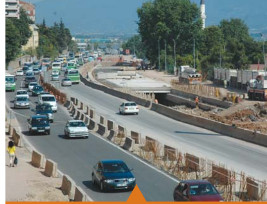
MESELA SEKA TÜNEL GEÇİŞİ
