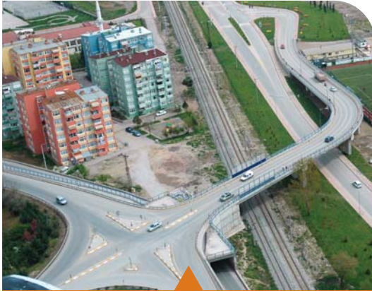
MESELA MEVLANA KÖPRÜLÜ KAVŞAĞI
