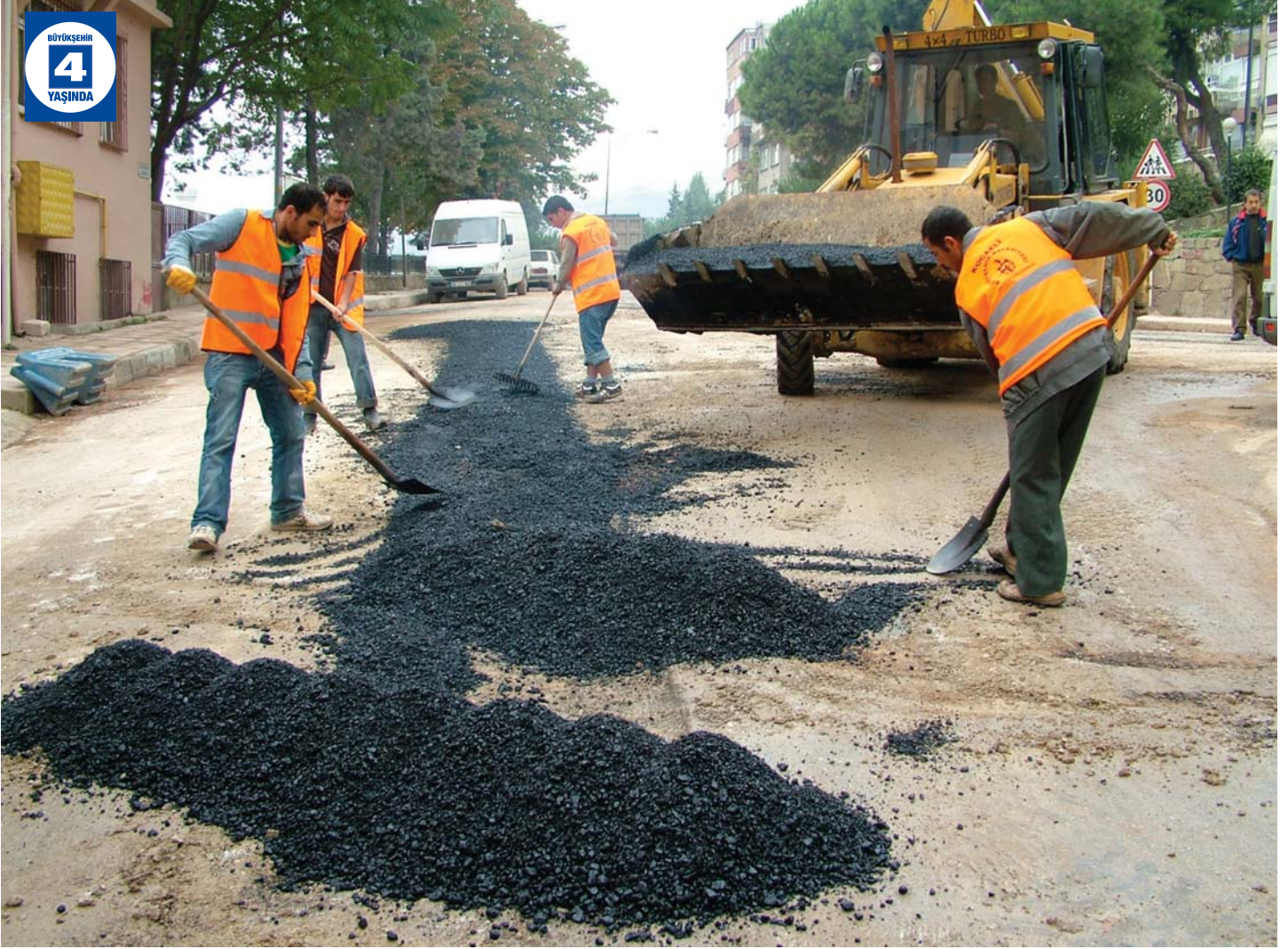
Asfalt Yama Çalışmaları
