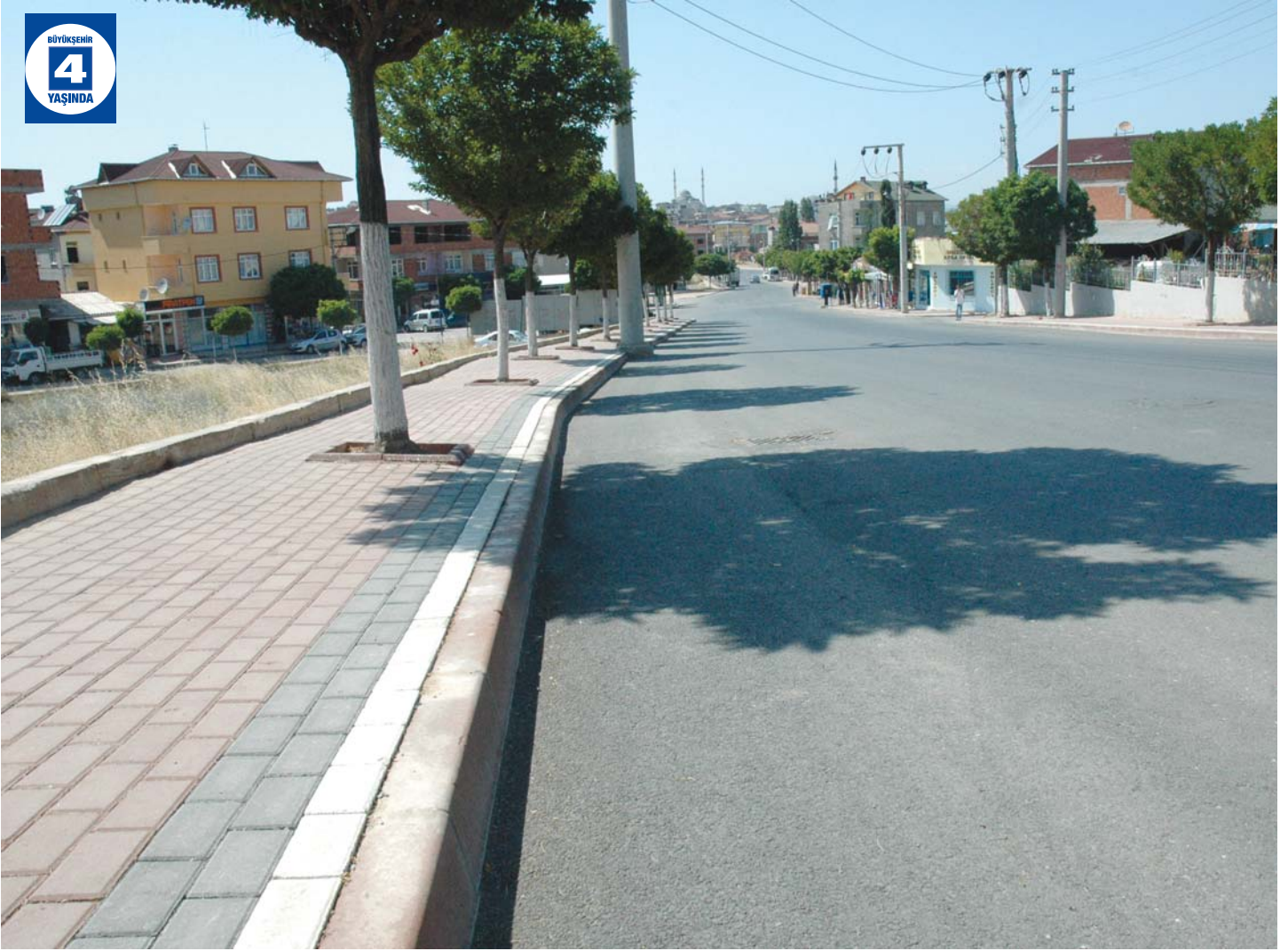
Caddelerde Üstyapı Düzenlemeleri
