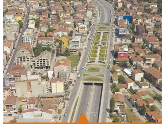
MESELA DERİNCE TÜNEL GEÇİŞİ
