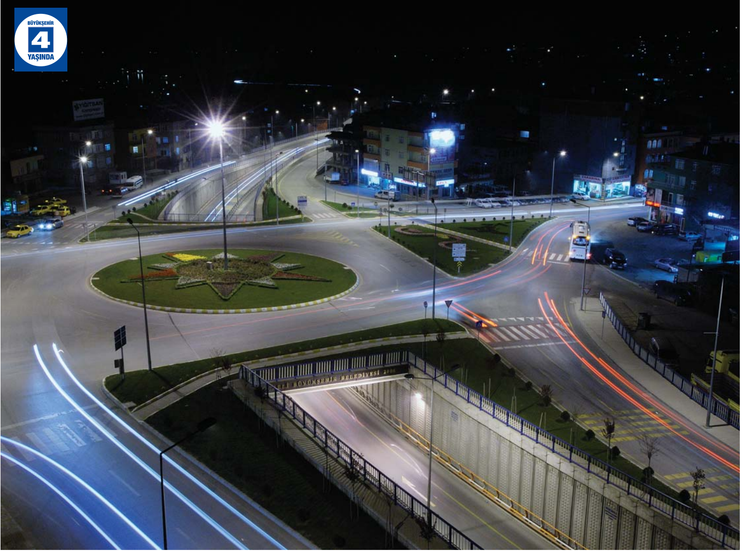
Darıca Eskihisar Köprülü Kavşağı
