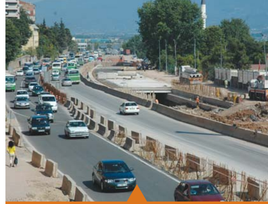
MESELA SEKA TÜNEL GEÇİŞİ
