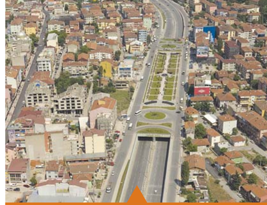
MESELA DERİNCE TÜNEL GEÇİŞİ
