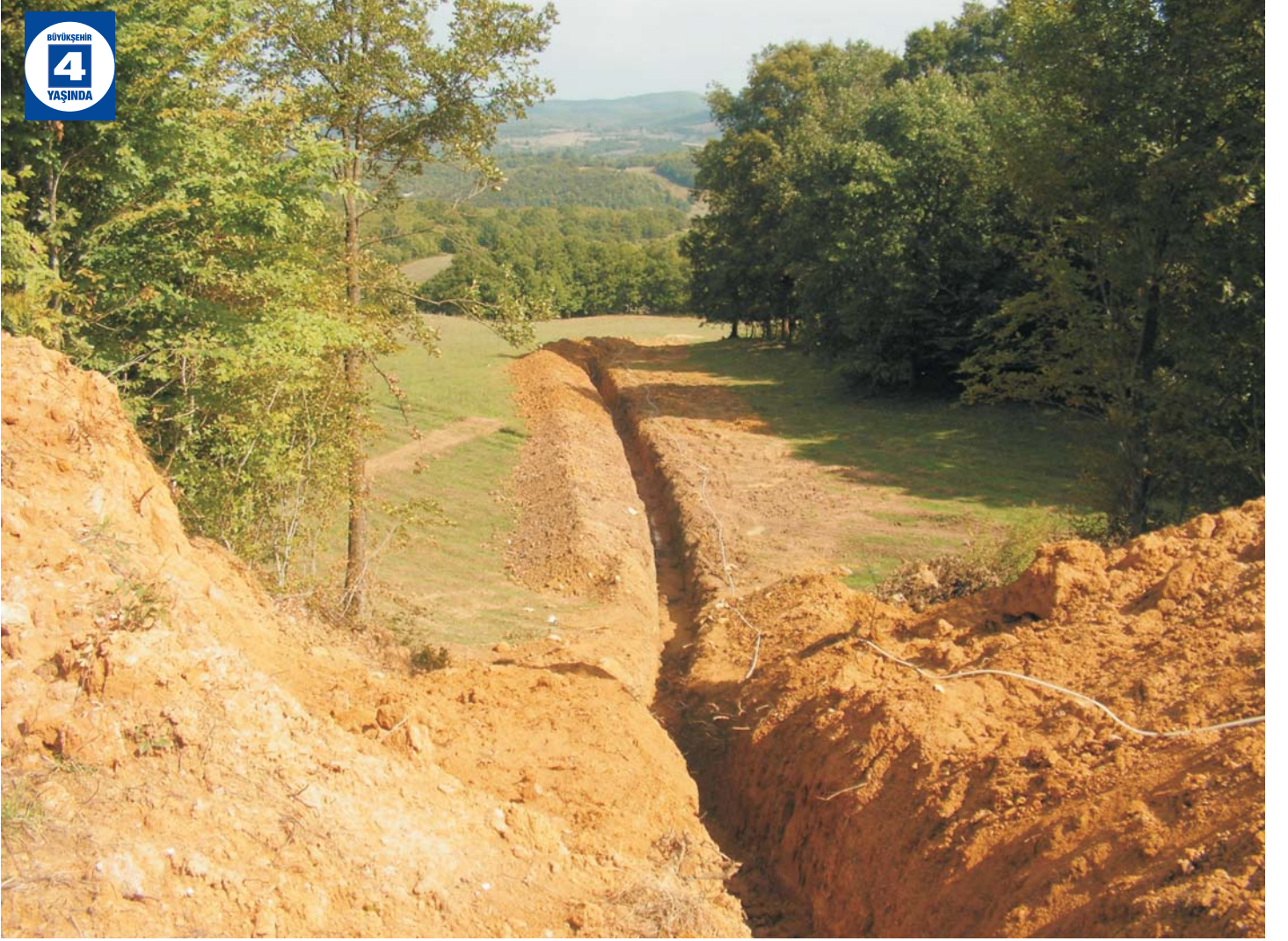
Köylerde Altyapı Çalışmaları
