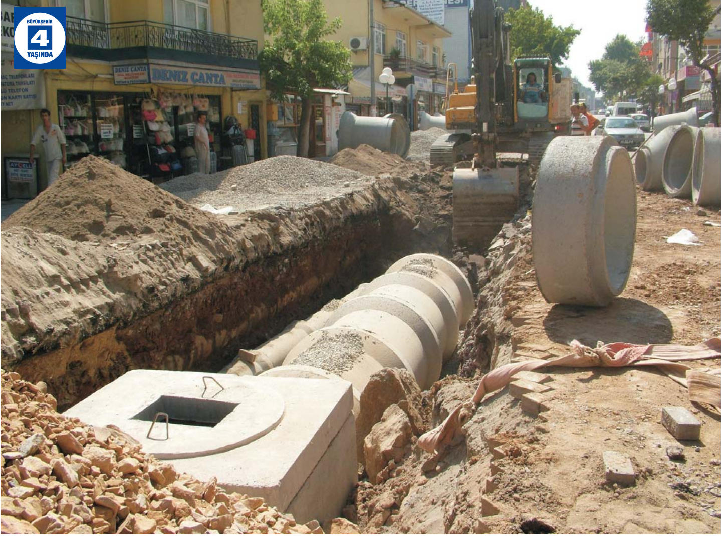
Denizciler Caddesi Kanalizasyon ve Yağmur Suyu Kolektör Hattı
