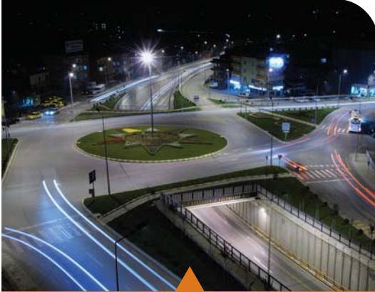
MESELA ESKİHİŐAR TÜNEL GEÇİŐİ
