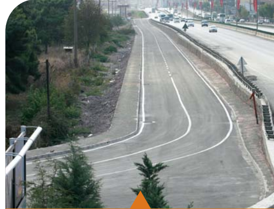
MESELA DERİNCE RO-RO YOLU
