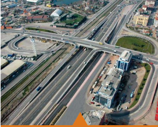
MESELA ADALET KÖPRÜSÜ
