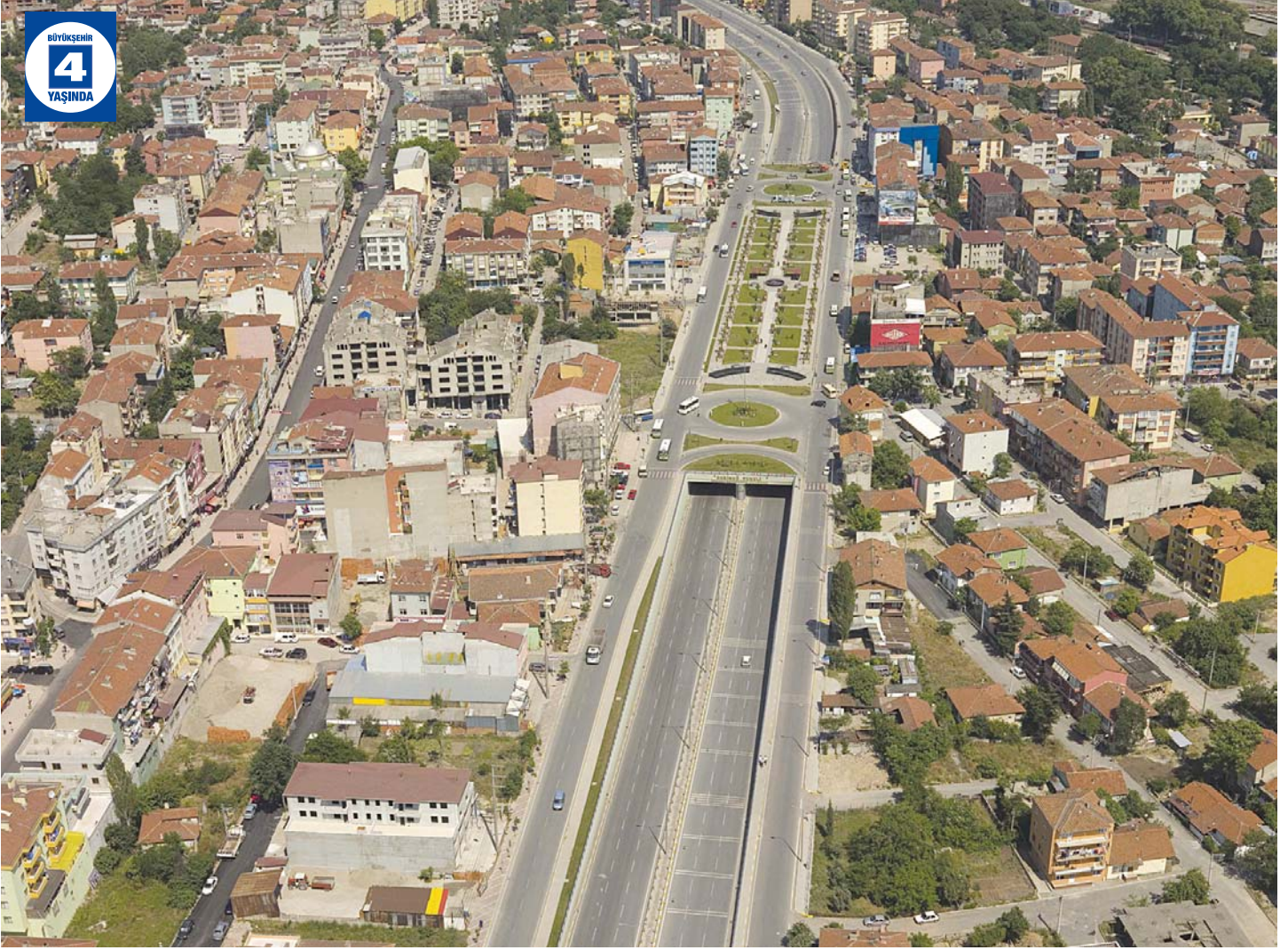
Derince D-100 Tünel Geçişi
