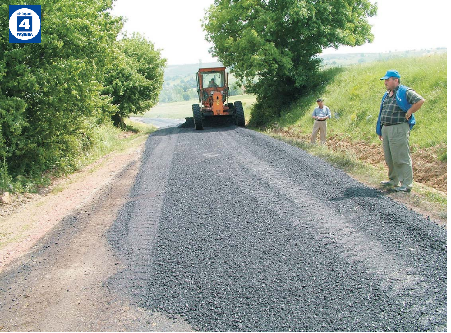
Köy Yollarında Asfalt Çalışmaları
