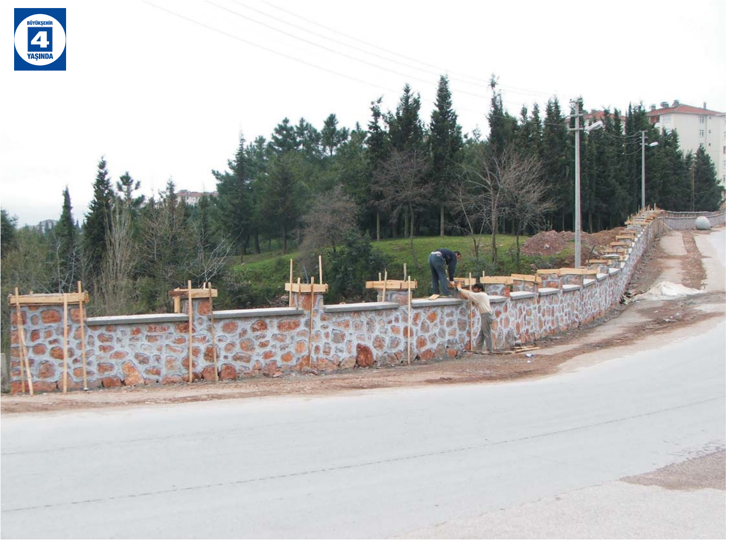
Derince Genelinde İstinat Duvarı Çalışmaları
