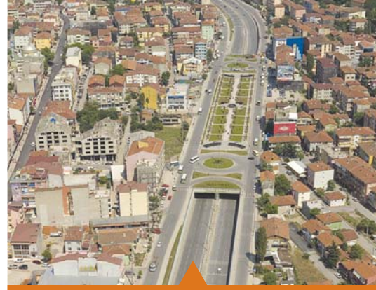
MESELA DERİNCE TÜNEL GEÇİŞİ
