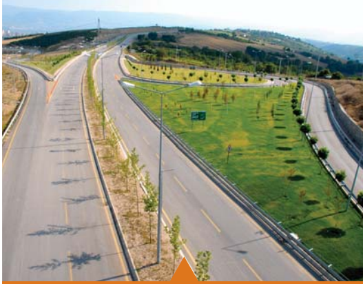
MESELA UMUTTEPE DUBLE YOLU
