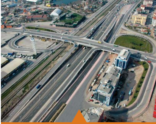
MESELA ADALET KÖPRÜSÜ
