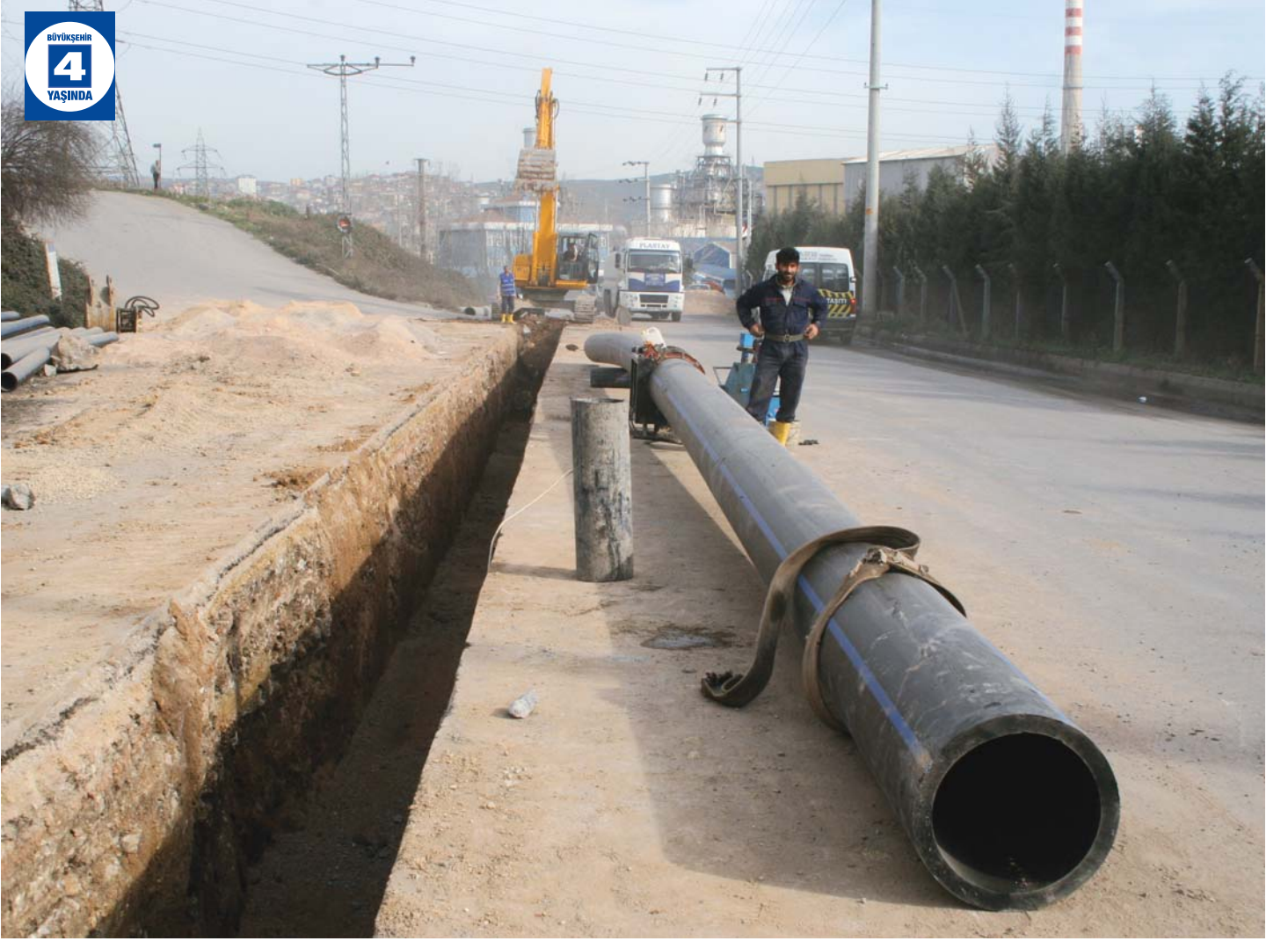
İçme Suyu ve Kanalizasyon Hattı
