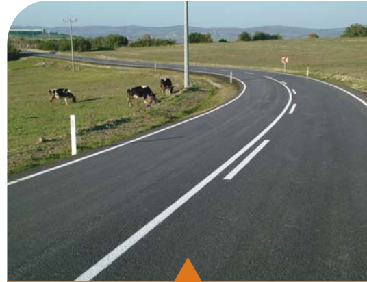
MESELA DEVELİ-AKÇAOVA YOLU
