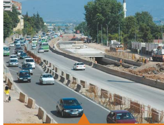
MESELA SEKA TÜNEL GEÇİŞİ
