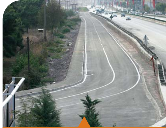
MESELA DERİNCE RO-RO YOLU
