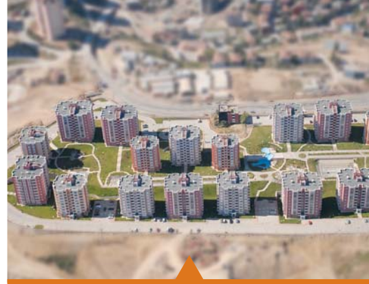
MESELA KENTSEL DÖNÜŞÜM
