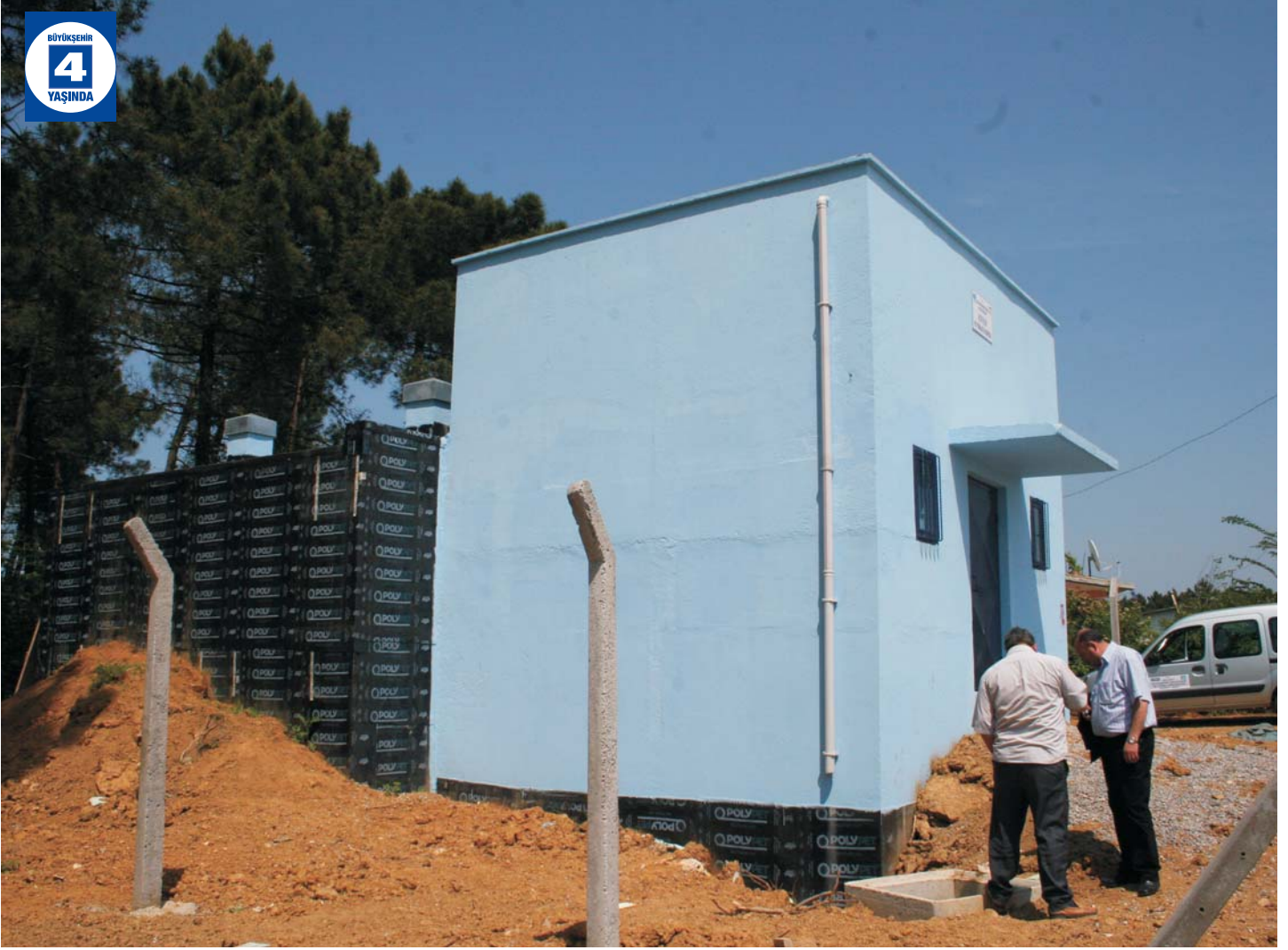
İçme Suyu Depoları
