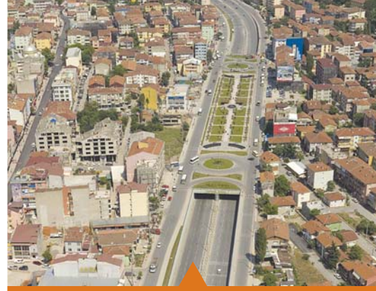
MESELA DERİNCE TÜNEL GEÇİŞİ
