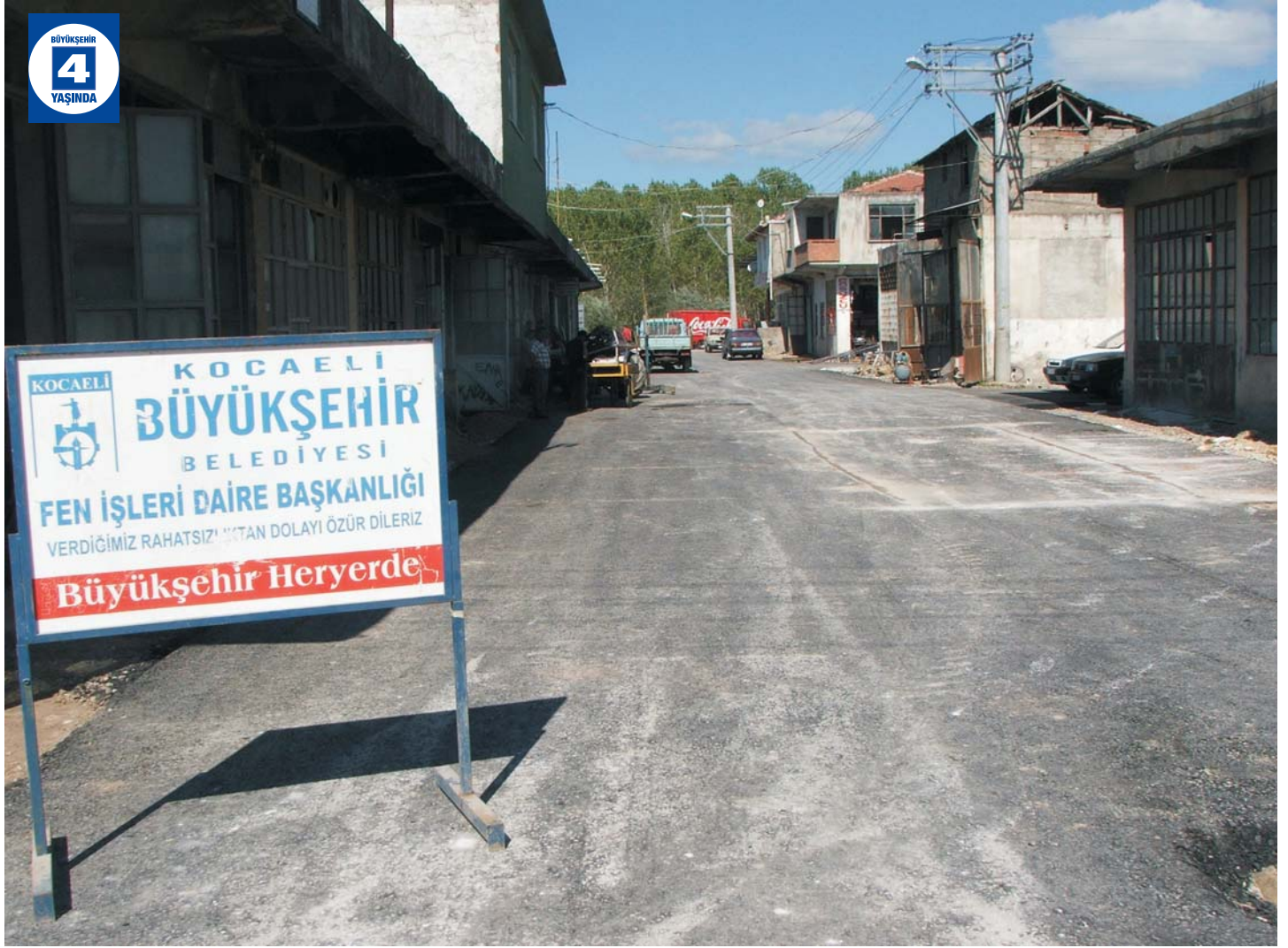
Kandıra Küçük Sanayi Sitesi asfalt serimi
