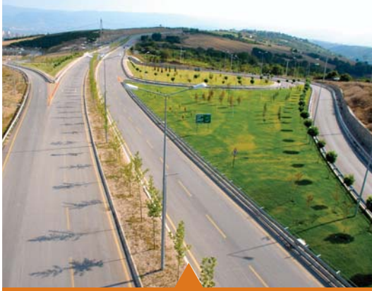
MESELA UMUTTEPE DUBLE YOLU
