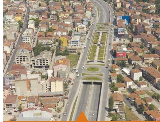
MESELA DERİNCE TÜNEL GEÇİŞİ
