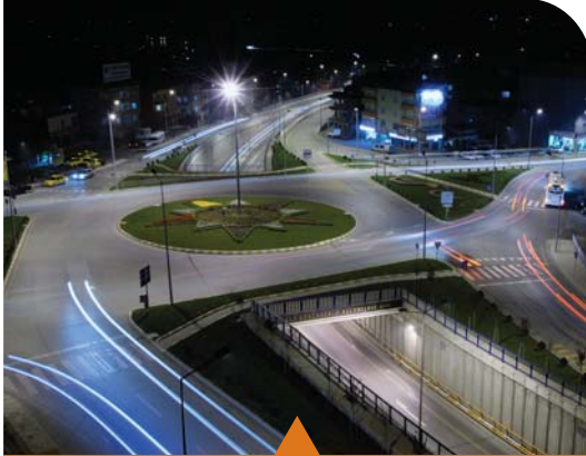
MESELA ESKİHİSAR TÜNEL GEÇİŞİ
