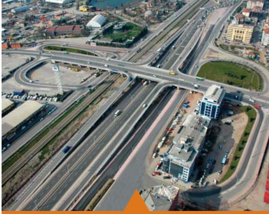
MESELA ADALET KÖPRÜSÜ
