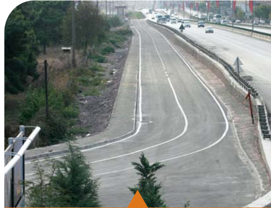
MESELA DERİNCE RO-RO YOLU
