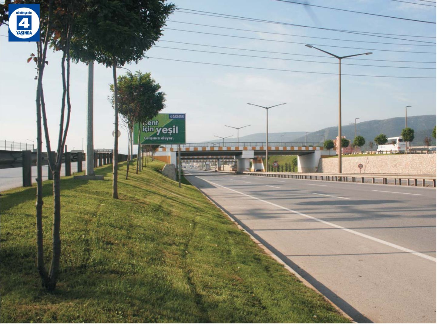
D-100 Karayolu - Kuzey Toplama Yolu üstyapı düzenlemesi
