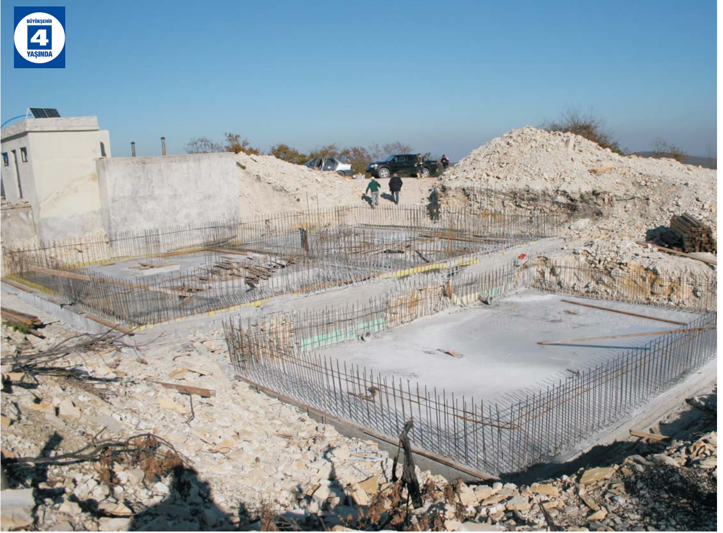
Köylerde Altyapı Çalışmaları
