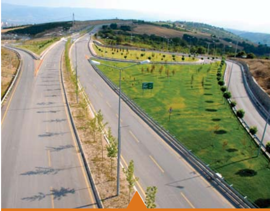
MESELA UMUTTEPE DUBLE YOLU
