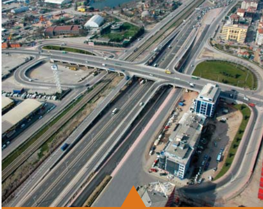
MESELA ADALET KÖPRÜSÜ
