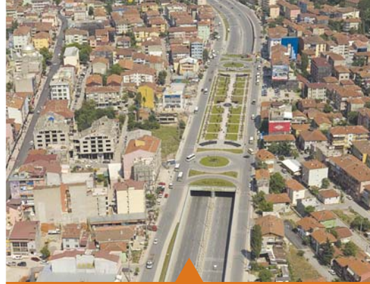
MESELA DERİNCE TÜNEL GEÇİŞİ
