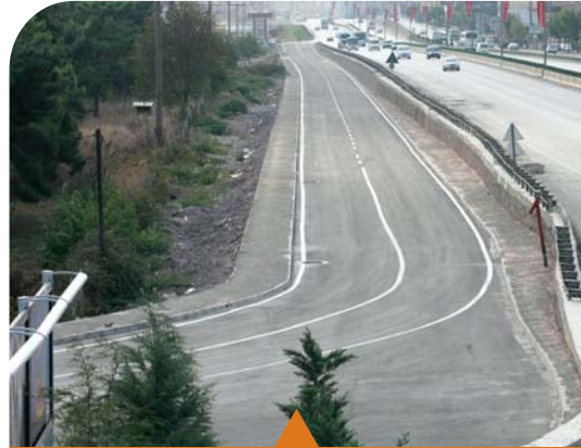
MESELA DERİNCE RO-RO YOLU
