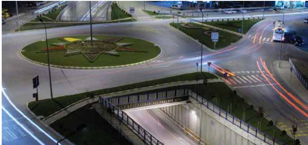
Eskihisar Tünel Geçişi
