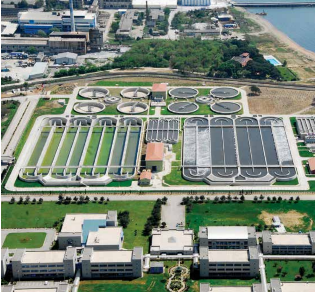
Gebze Atıksu Arıtma Tesisi
