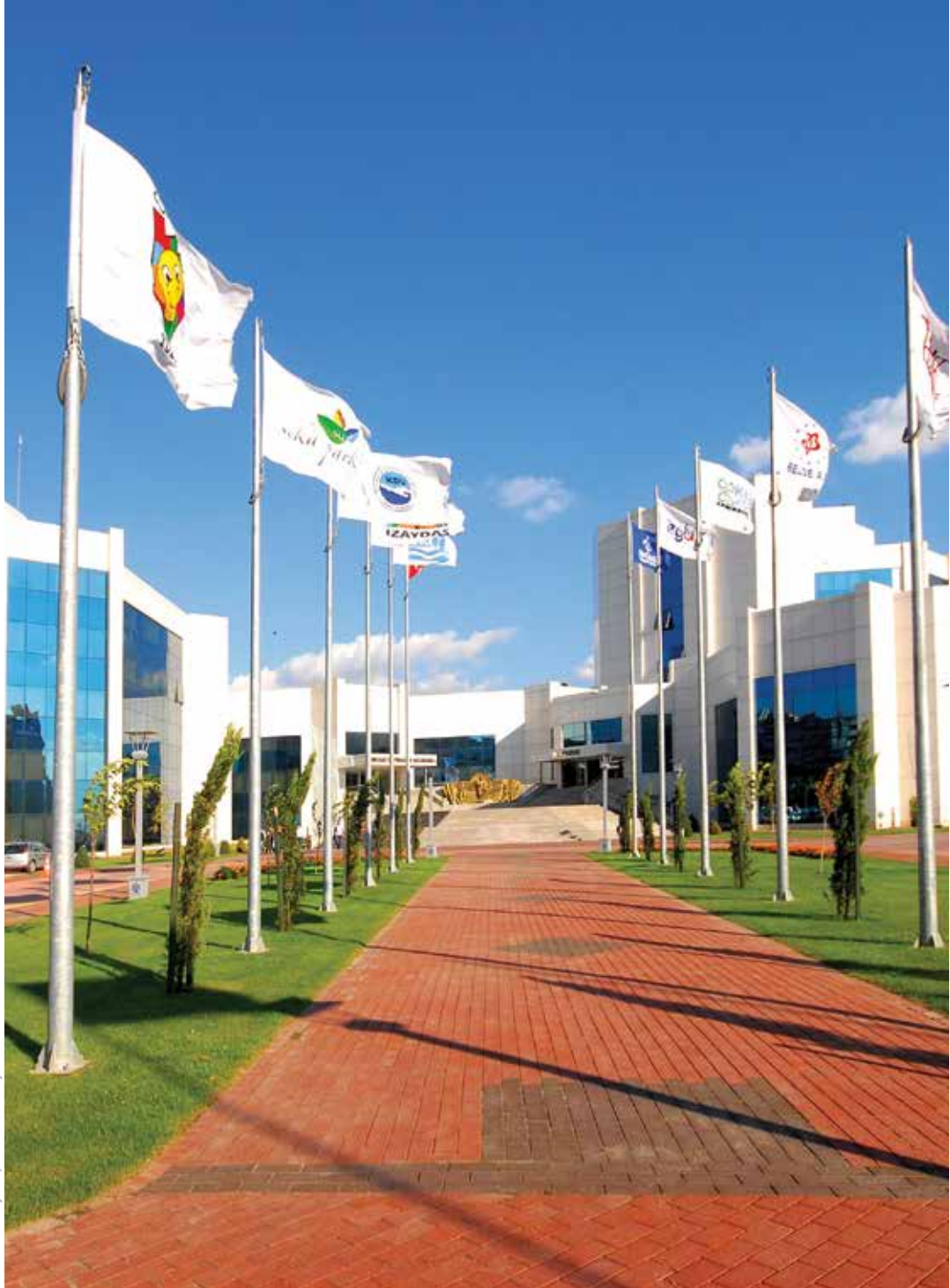
Kocaeli Büyükşehir Belediyesi Hizmet Binası
